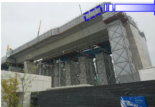
防音シート組立
